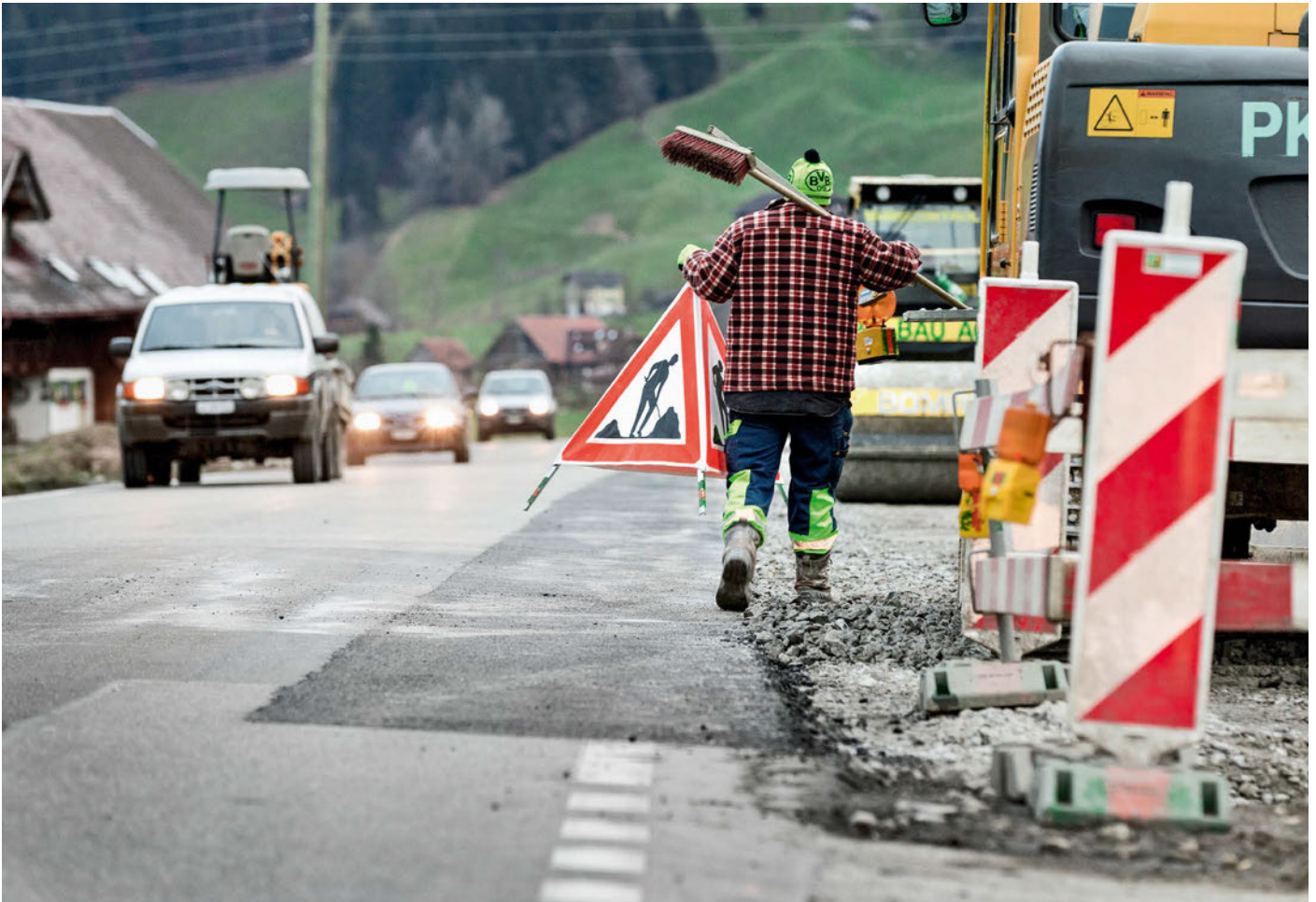
Der erste Abschnitt des Radwegs Marbach–Wiggen soll 2015 fertig gebaut sein.
